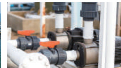
建筑工地供水
